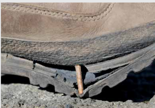
VÄLIPOHJA on haurastunut koko pohjan alalta, mutta se on paljastunut vasta reunan pettäessä.
